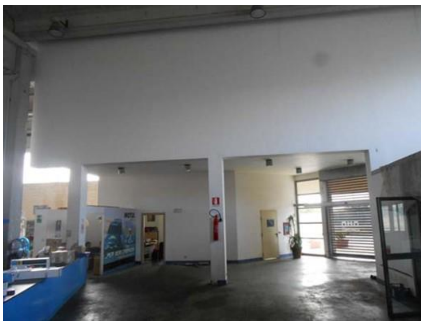
Figura 27 – Ingresso (struttura in c.a. ingresso con piano rialzato)
