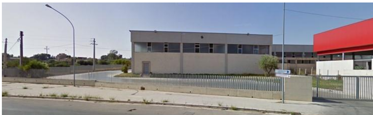
Figura 4 - Accesso al fabbricato artigianale – Ingresso principale
