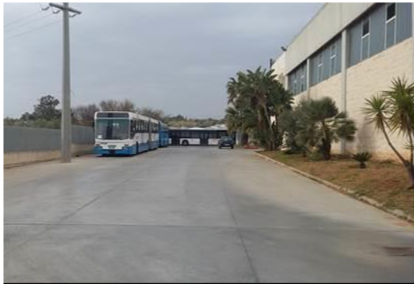
Figura 22 – Fabbricato artigianale – prospetto ovest
